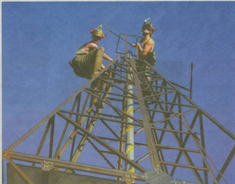
Twee gehelmde oliemannen in de boortoren die nu nog op het Shellterrein staat. Volgende week brandt de boortoren van theatergroep De Jonge Honden in het Ter Pelkwijkpark. foto Frans Paalman
